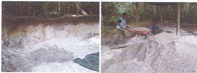
Imagen No. 15 y 16 muestra el proceso de extracción de tierra blanca caliza del banco de tierra, carreteándola hacia el lugar donde carga el camión para su traslado.
